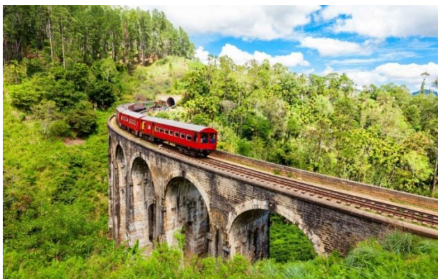
Nine Arch Bridge, Ella
